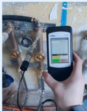
Fig. 2.19 « Procéder à un essai d'étanchéité de conduites d'eau potable »
